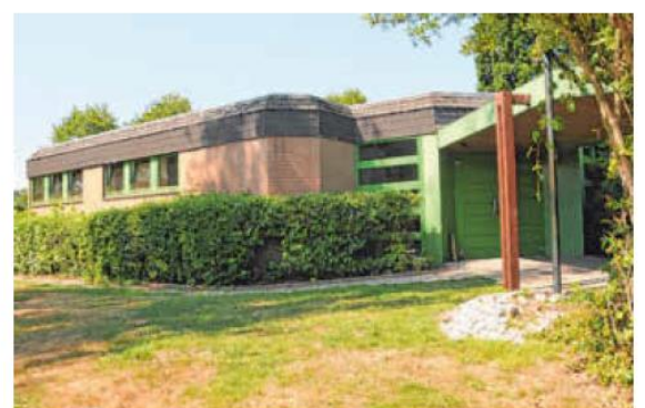
Zentraler Punkt: Abriss, Neubau oder Renovierung – noch ist die Zukunft des Gemeindehauses unklar. Laut Gutachten aber immens wichtig.
