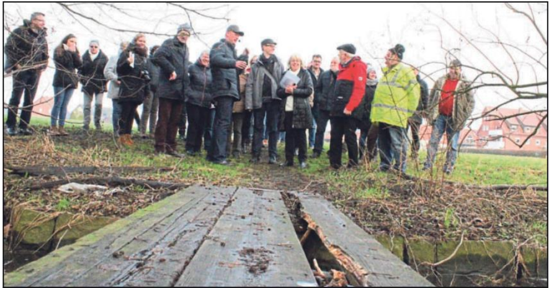
Die Bretter werden morsch: In Hörste überlegt man deshalb, eine kleine Brücke als Übergang vom Feuerwehr-Gerätehaus zur Vermolder Straße zu bauen. Foto: Malte Krammenschneider
